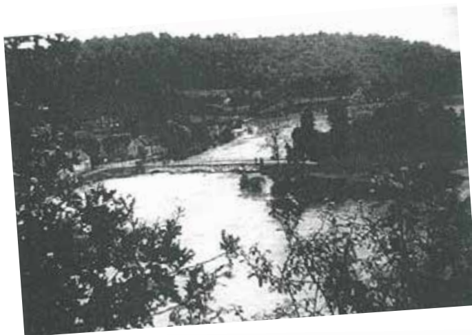
Pont de la route en direction d'Evaux-les-Bains à Chambon-sur-Voueize, crue de la Tardes en octobre 1960 © archives communales de Chambon-sur-Voueize.
