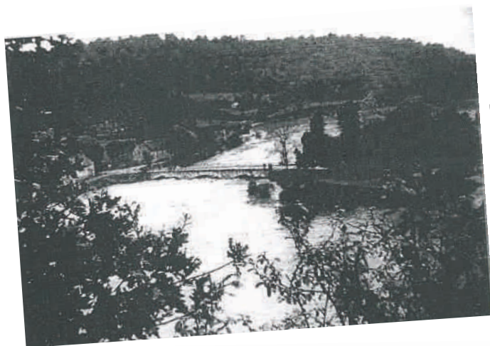
Pont de la route en direction d'Evau-les-Bains à Chambon-sur-Voueize, crue de la Tardes en octobre 1960 © archives communales de Chambon-sur-Voueize.
